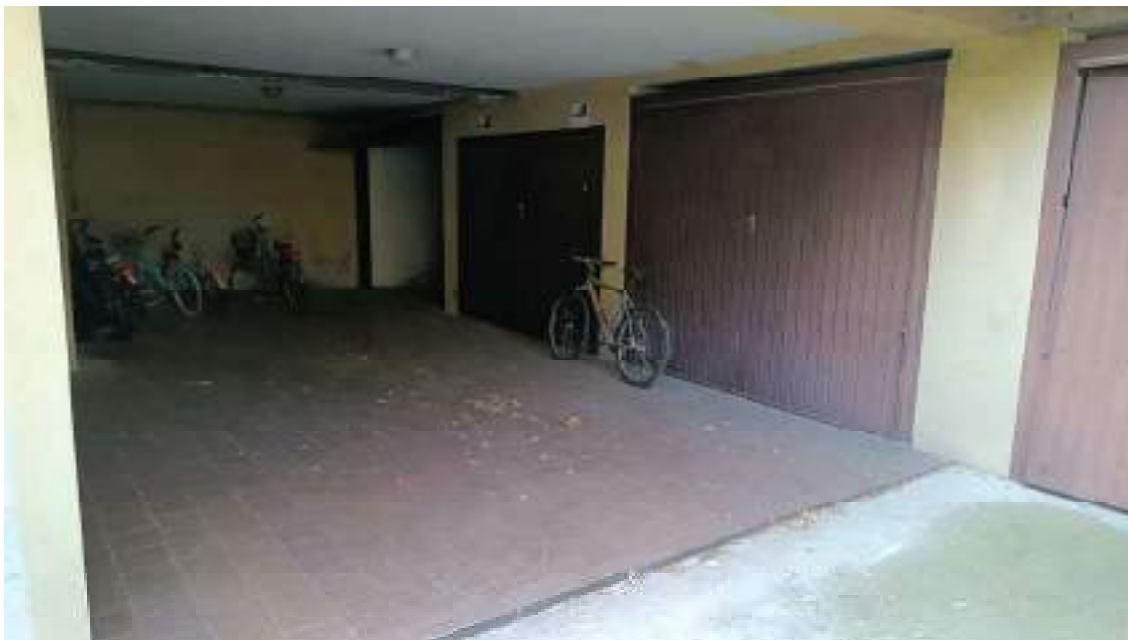
007 - PARTICOLARE ACCESSO AUTORIMESSE
