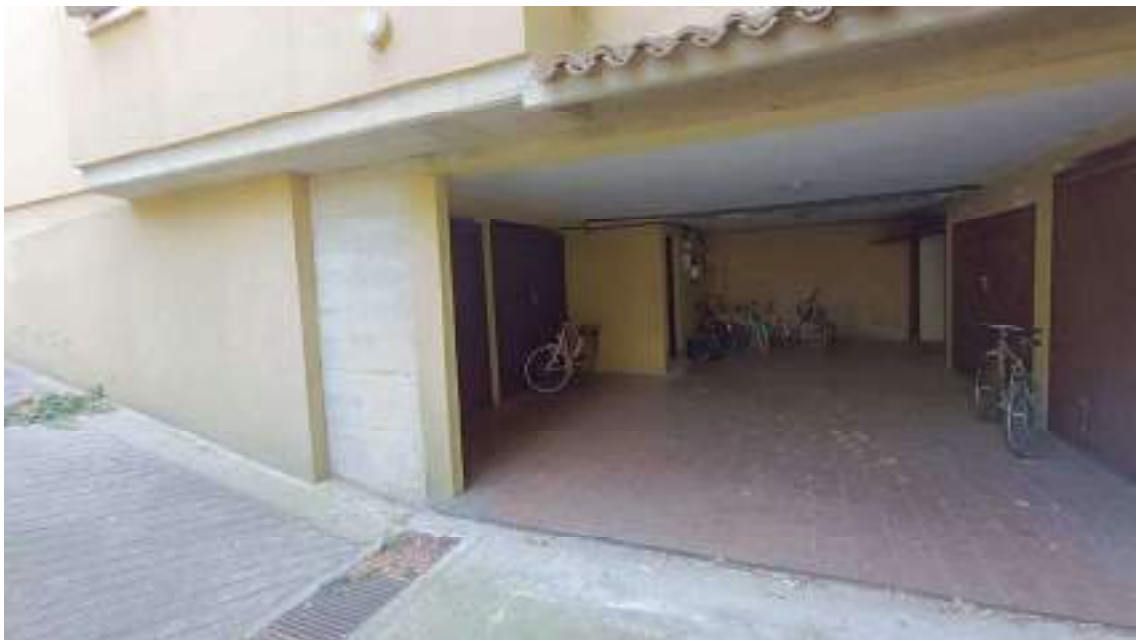
006 - PARTICOLARE ACCESSO AUTORIMESSE
